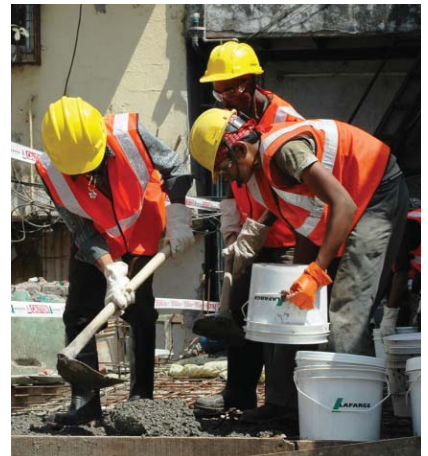
Projekt dostupného bydlení, dodávka betonu na stavbu komplexu nízkonákladového bydlení v Indii
