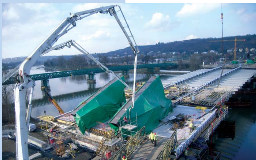
Foto ze stavby, za cca 2,5 měsíce se přes řeku vysunul rošt z příčníků a dvou příhradových konstrukcí
