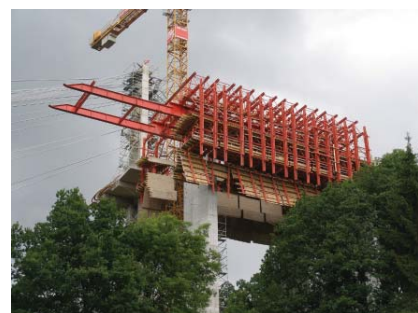
obr. 5 – Skruž se sklopeným bedněním při přesunu
