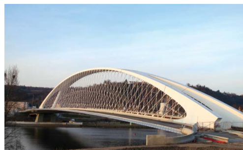
Stav mostu v březnu 2014
