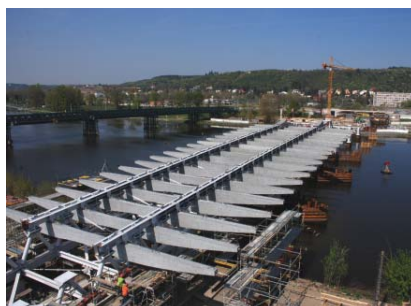
Foto ze stavby, za cca 2,5 měsíce se přes řeku vysunul rošt z příčníků a dvou příhradových konstrukcí
