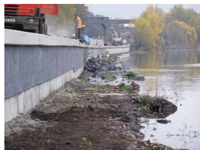
Na trase vyrostly opěrné gabionové zdi
