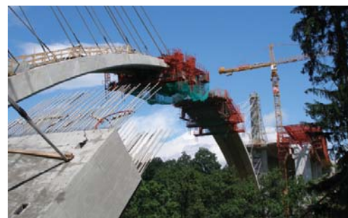
obr. 3 - Betonáž oblouku levého mostu dvěma vozíky
