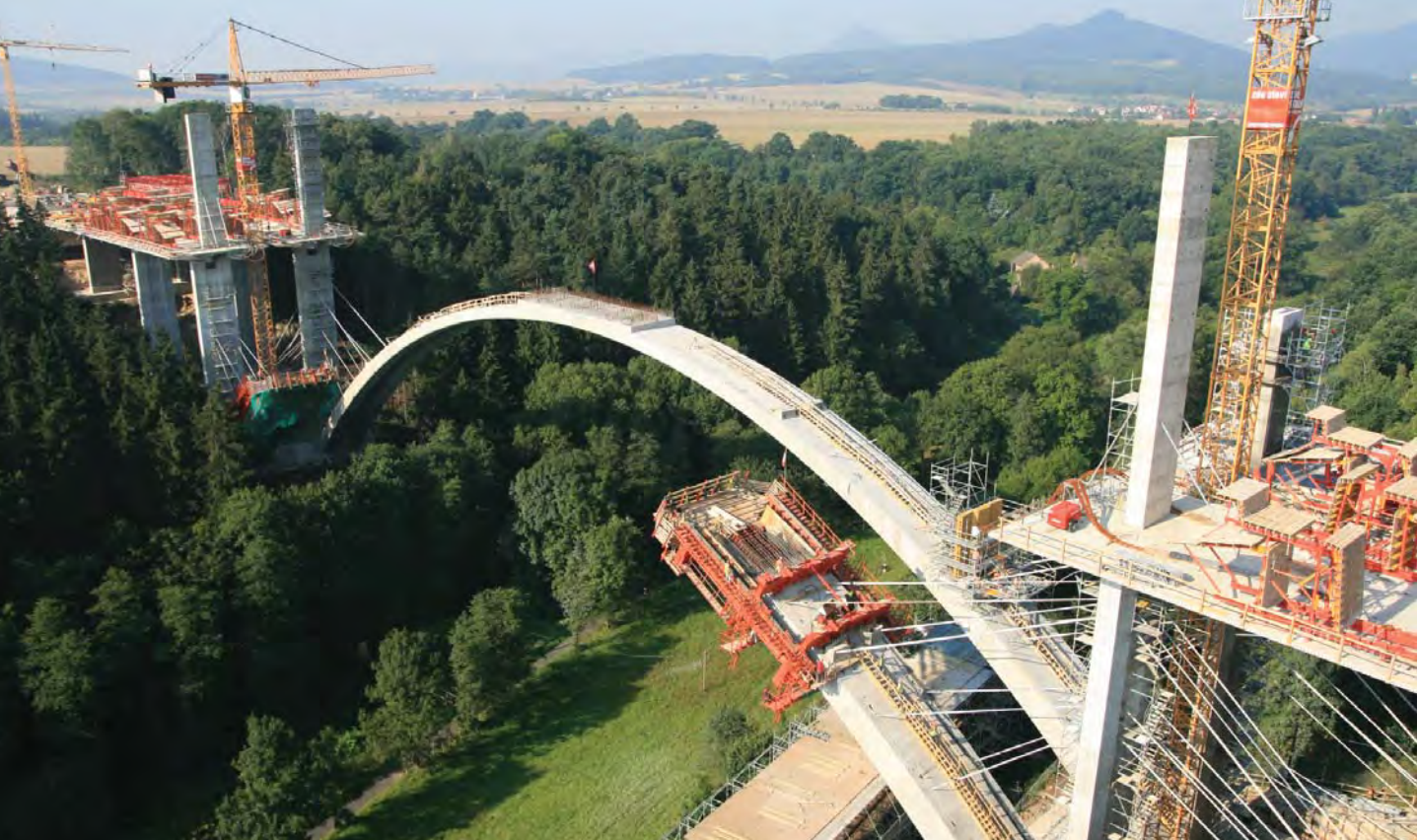
Stavba oblouku Oparno, D8 Foto: Archiv Metrostav
