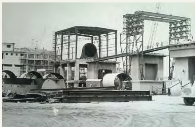
výstavba základů pro rotační pec vápenky
