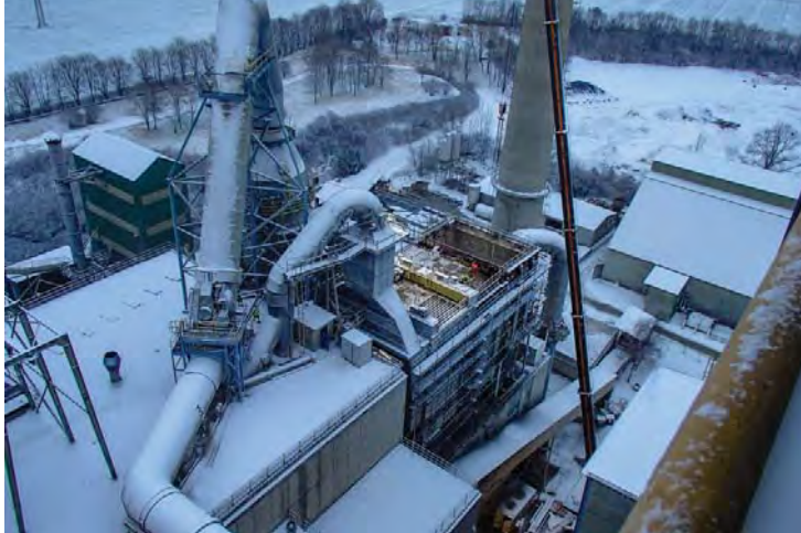
Zimní pohled na otevřenou střechu filtru během rekonstrukce
