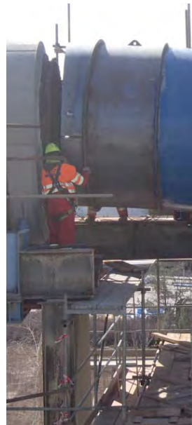
Montáž tlumiče hluku odtaňového ventilátoru o hmotnosti 25 tun
