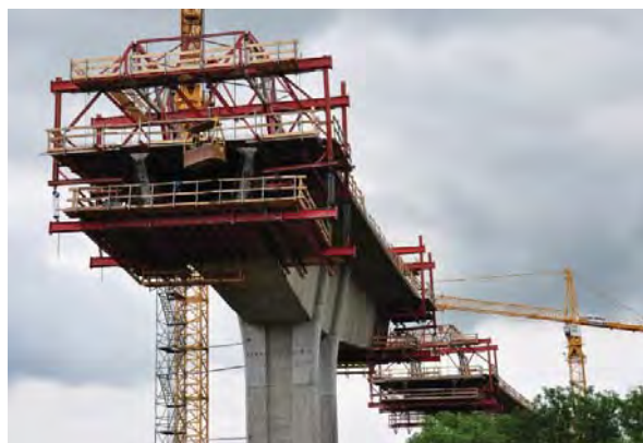
Betonážní vozík mostu Velemyšleves Foto: Helena Včelová
