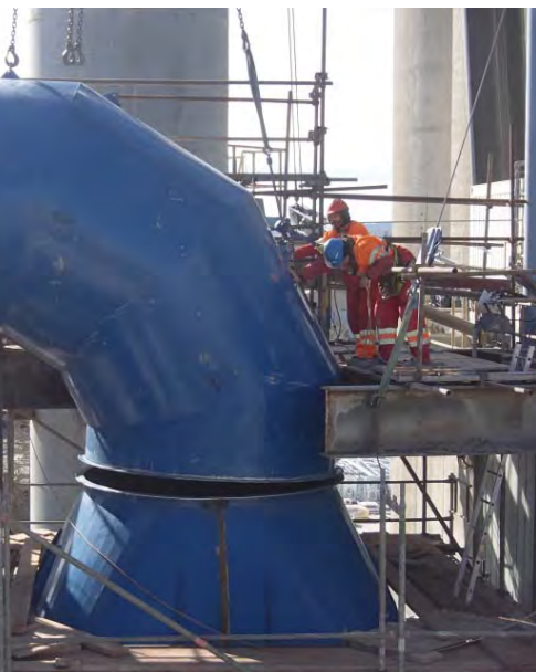
Montáž kolena nad tlumičem hluku
