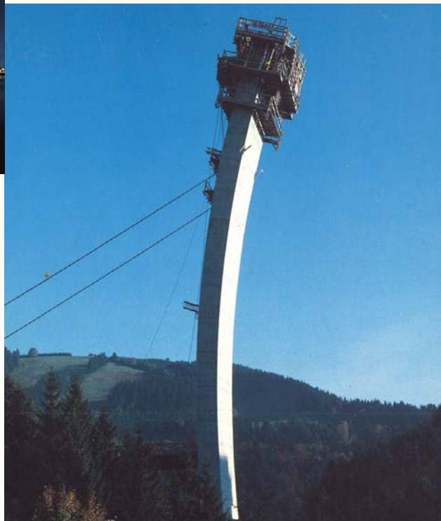
Most Argentobel – betonování poloviny oblouku Foto: Vorspann-Technik
