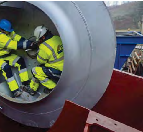
Montáž oběhového kola odtahového ventilátoru
