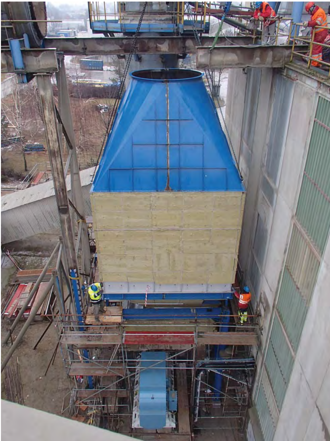
Montáž tlumiče hluku odtaňového ventilátoru o hmotnosti 25 tun
