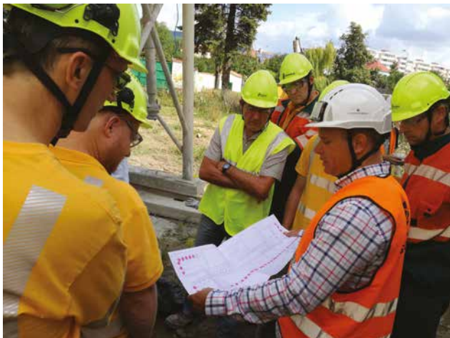
Trysková injektáž základů cementem firmou SOLETANCHE
