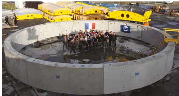
Obr. 14 (dole) Segmentový prstenec tunelového ostění pro silniční tunel v Seattlu (16 m v průměru, tloušťka 0,5 m).
