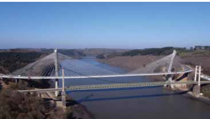
Původní most, na snímku v popředí, již v devadesátých letech kapacitně nevyhovoval
