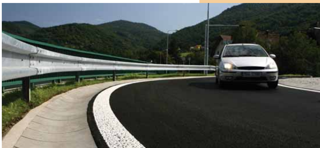
Společnost CS-BETON z Velkých Žernosek vyrábí prvky pro stavbu silnic a dálniční sítě
