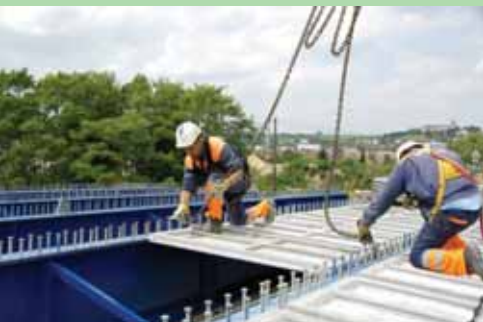
Osazování jednotlivých panelů na stavbě
