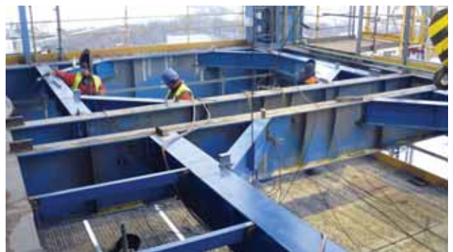
Při práci na stavbě musely být dodržovány všechny bezpečnostní normy
