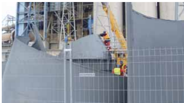
Stavba si vyžádala instalaci 100 t oceli
